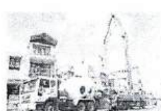
Bơm bê tông
